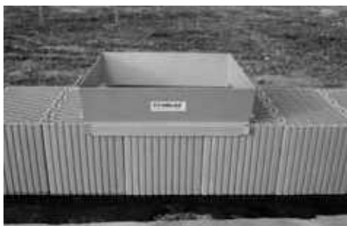
Pierwsza warstwa bloczków przygotowana do zasypu
